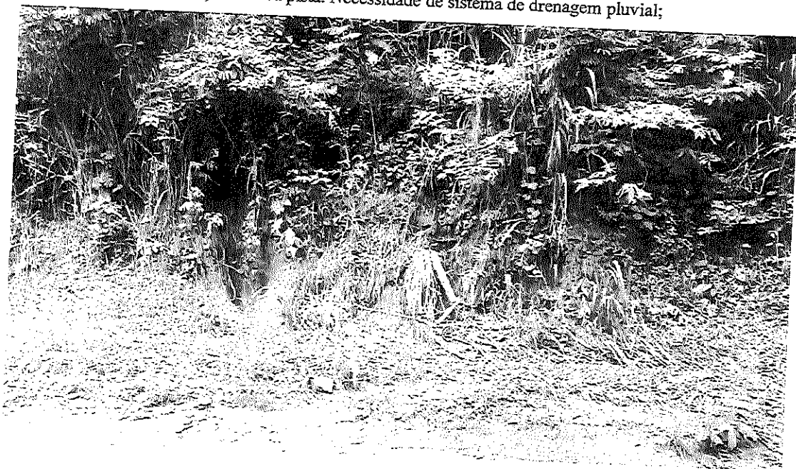
Foto 06: Trecho com necessidade de implantação de descida d'água.;
